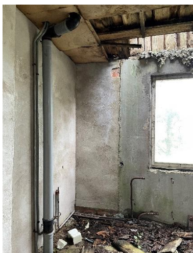
Telpa ar mitruma bojātajām griestu/pārsegumu konstrukcijām
